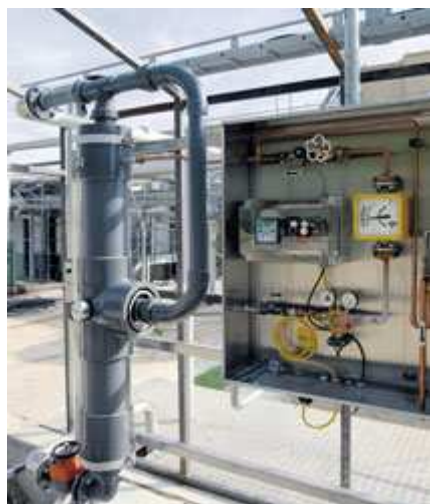
Exempel på doserutrustning för CO 2 i avloppsvatten (källa: AGA)
