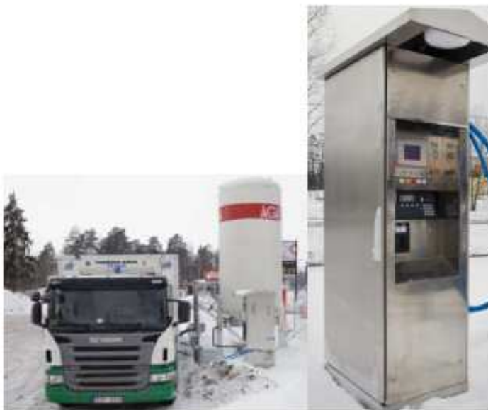
Tankställe för flytande koldioxid (källa: AGA)
