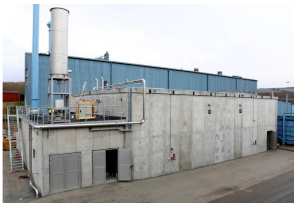
Torrötning i horisontell röt-kammare enligt pluggflödesteknik (Eisenmann)
