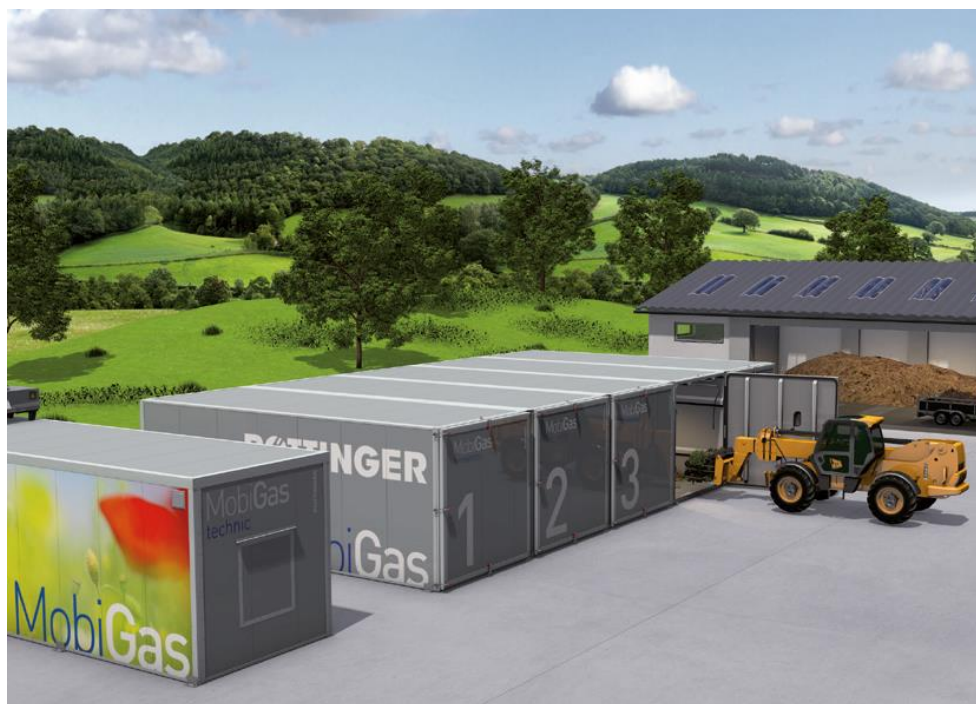
Satsvis torrötning i modulsystem (Pöttinger – Mobigas system)
