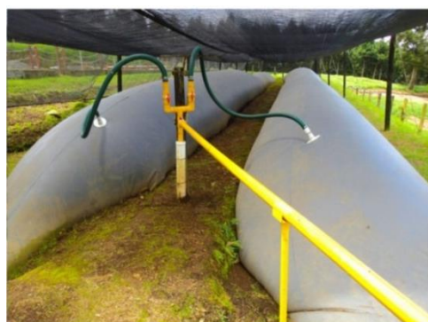
Dubbla rötkammare av slangtyp 60-120 m 3 /st
