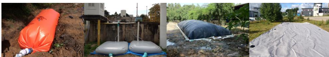
Enkla biogasanläggningar enligt pluggflödesprincipen tillverkade av membranduk, installerade i bl.a. Indonesien och Vietnam. Tillverkade i Sverige av FOV Fabrics ( www.fovbiogas.com )
