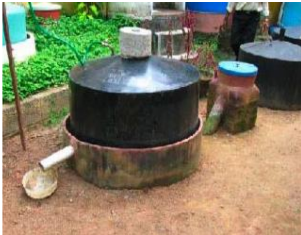
Enkel lokalbyggd biogasanläggning med flytande tak i Indien (S. Lansing & A. Moss, University of Maryland, 2009)
