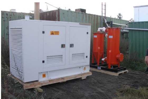
Test på en svensk gårdsbiogasanläggning av ett kinesiskt biogasset på 20 kW el. De orange behållarna t.h. är svavelreningfilter. (Foto: TecnoFarm)
