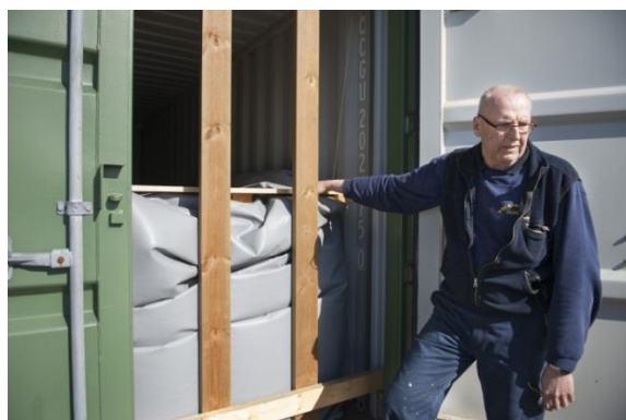
Lager för biogas i membransäck som placerats inne i en standard container på en svensk gårdsbaserad biogasanläggning. Lastpallar ovanpå säcken ger ett gastryck samt ger en nivågivare signal om hyr mycket som finns i lagret. ( www.gardsgas.se )
