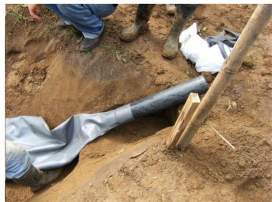
Inloppet till rötkammaren
