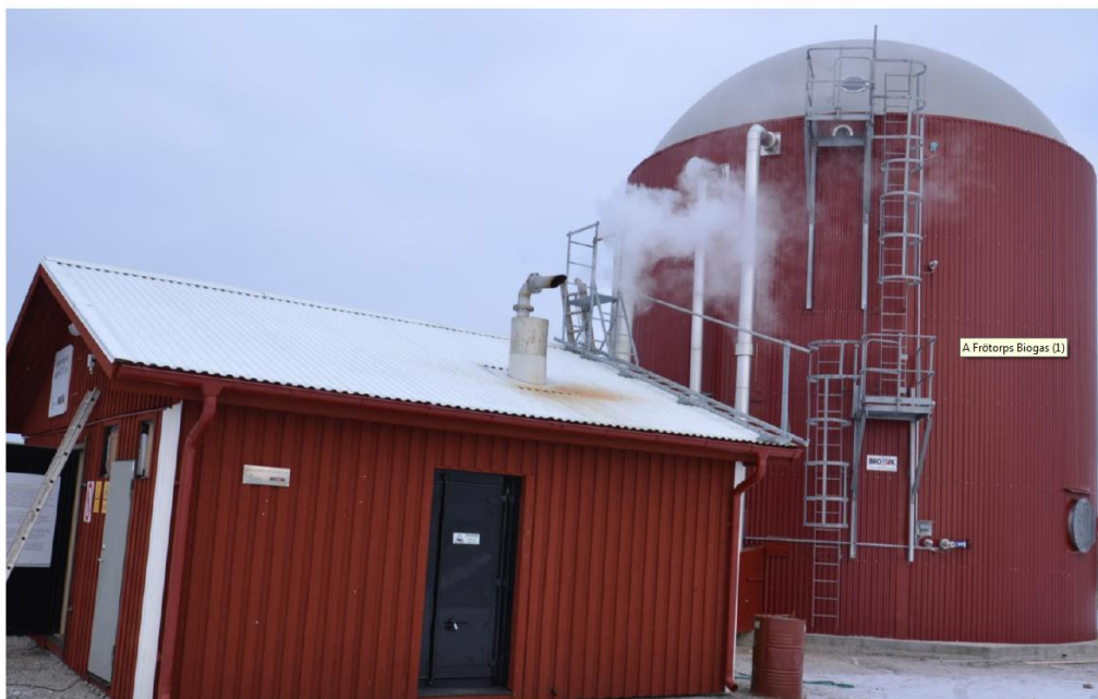
En svenskbyggd gårdsbiogasanläggning med en 550m 3 rötchammare som rötar 7000 m 3 svingödsel/år med en eleffekt på 50 kW. Levererad av Byggplant /Browik (Foto: Hushållningsällskapet)
