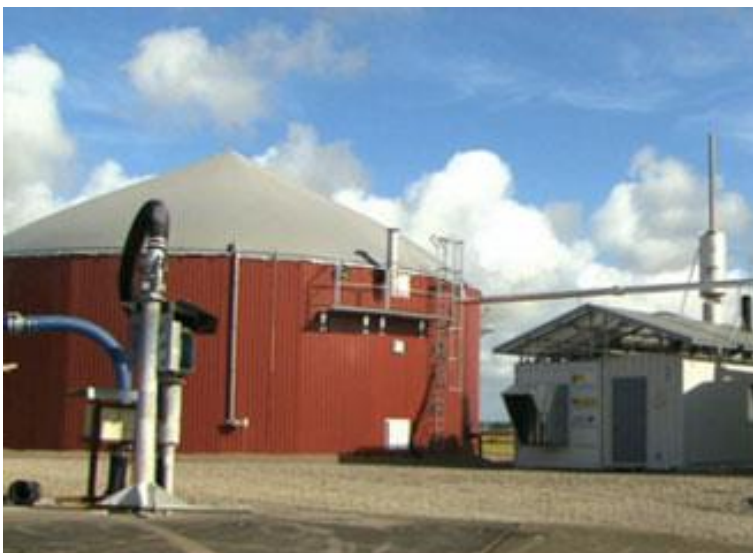
Exempel på en svensk gårdsanläggning för våtrötning levererad av Norups Gård ( www.norup.se )
