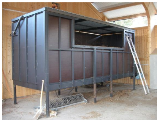
SWEBO – Matningsficka för fasta bränslen här höstgödsel
