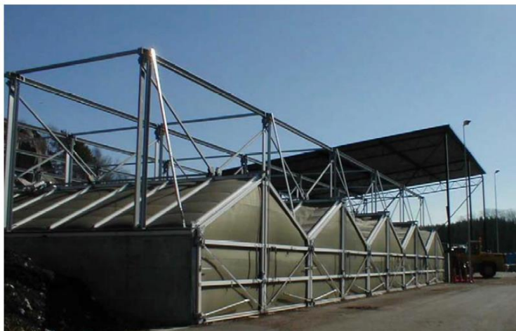
Membrankompostering vid Bubbtorp, Karlskrona (RVF Utveckling 2005:06)
