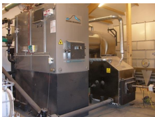
SWEBO – Biotherm Gen.3 Biobränslepanna som kan som kan elda otorkad hästgödsel med tillsats av en mindre mängd träpellets Exempel Håggebylunds gård, Bålsta
