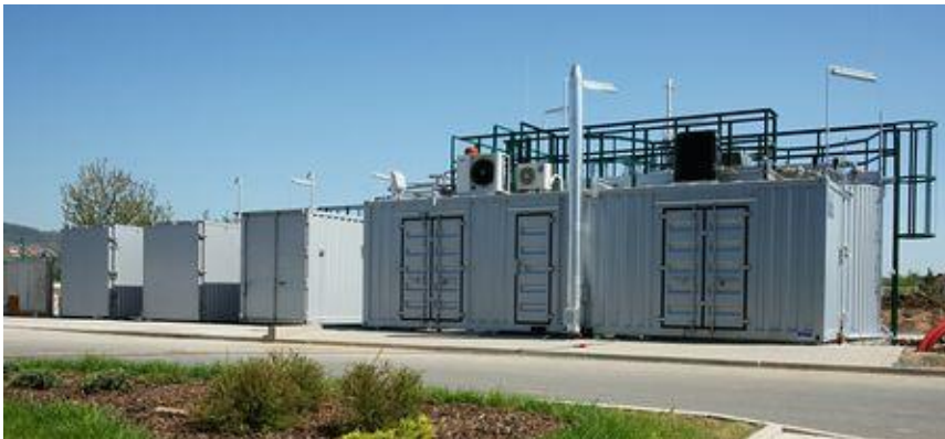
Hennlich– AlphaFERM - Tjeckisk modulbyggd biogasanläggning för torrrotning. Systemet har testats med hästgödsel men inte i kommersiell produktion. ( www.hennlich.cz )
