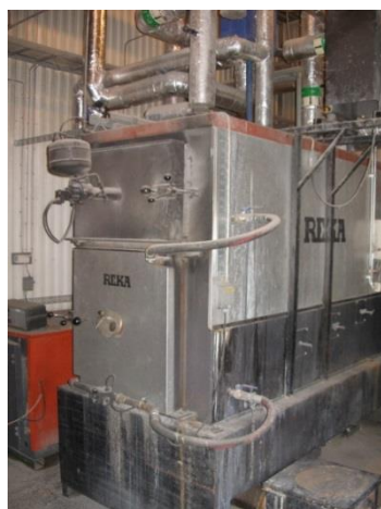
REKA – Biobränslepanna som kan elda torr hästgödsel (Taxinge Gods, Nykvarn)
